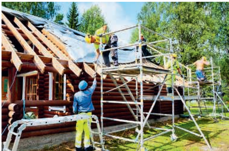
Tuomirannan talkoiden ensimmäinen vaihe alkamassa kesällä 2016. Vanha, sinänsä hyväkuntoinen katto purettiin, lämpöeristystä lisättiin ja rakennettiin uusi katto. Ahkerat ja toimeliaat talkoolaiset vauhdissa.
