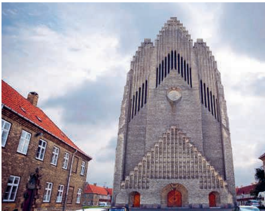
Kööpenhaminan Grundtvigin kirkon julkisivu muistuttaa kirkon urkua.
